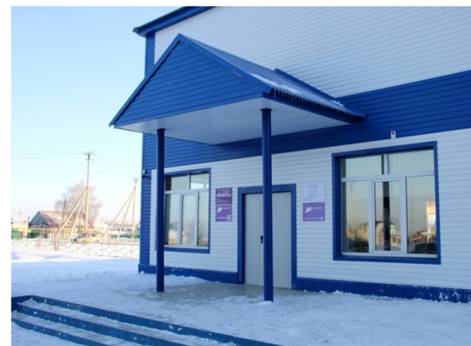
Капитальный ремонт ДК с.Калиновка
