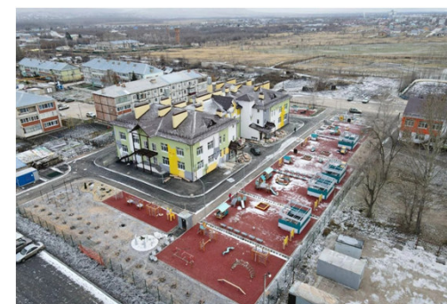
Капитальный ремонт здания ГБОУ СОШ. Строительство детского сада на 170 мест (пос. Сургут)
