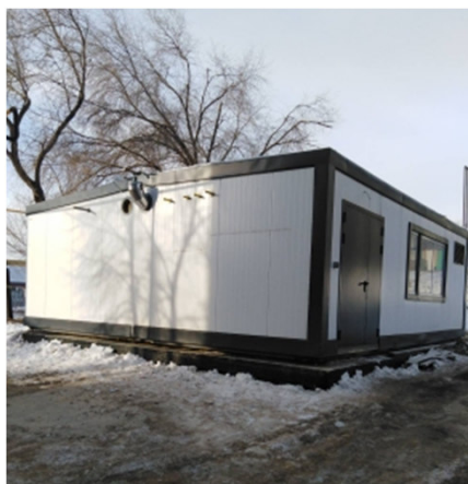
Строительство модульной котельной в п. Серноводск, ул. Калинина, установленной мощностью 2,18 МВт
