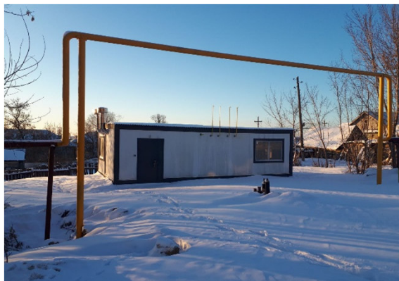
Строительство модульной котельной в п. Серноводск, ул. Революции, установленной мощностью 0,77 МВт
