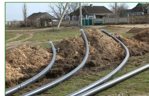
Строительство сетей водоснабжения в с. Кармало-Аделяково
