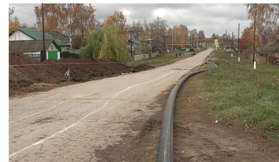
Строительство сетей водоснабжения в с. Кутузовский
