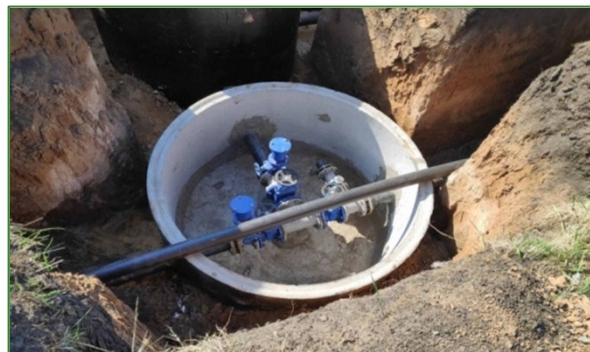
Проектирование и строительство водопроводных сетей в с. Калиновка
