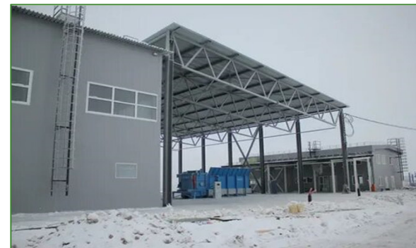
Строительство мусоросортировочного комплекса, рассчитанного на обработку до 80 тысяч тонн отходов ежегодно
