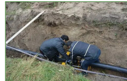
Строительство водопроводных сетей в с. Нероновка
