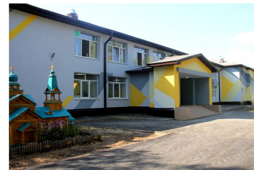
Капитальный ремонт ГБОУ СОШ (с. Кандабулак)
