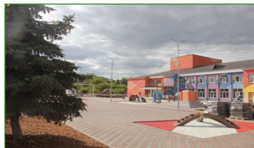
Комплексное развитие п. Светлодольск (кап. ремонт ГБОУ СОШ, дома культуры, строительство сетей водоснабжения и водоотведения)
