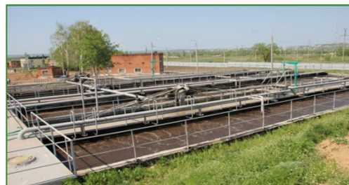
Реконструкция канализационных очистных сооружений (с. Сергиевск, п.г.т. Суходол, п. Сургут)
