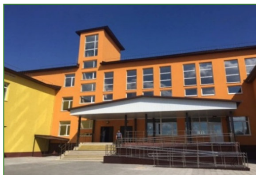
Реконструкция здания Сергиевской школы №1 под общеобразовательный центр (с. Сергиевск)
