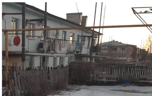
Строительство сетей водоснабжения к проектируемой малоэтажной застройке в с. Черновка
