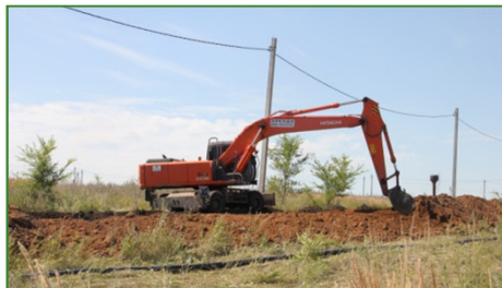
Строительство водовода для Сергиевского пансионата для ветеранов войны и труда (с. Кандабулак)
