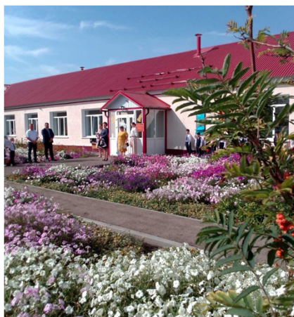
Капитальный ремонт ГБОУ ООШ (с. Сидоровка)
