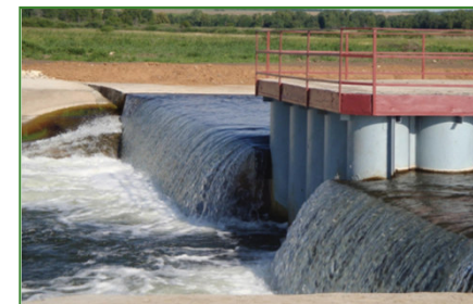
Проектирование и строительство Сергиевского группового водопровода (с. Сергиевск)
