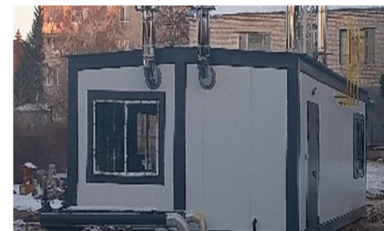
Строительство модульной котельной в п. Серноводск, ул. Советская, установленной мощностью 0,3 МВт
