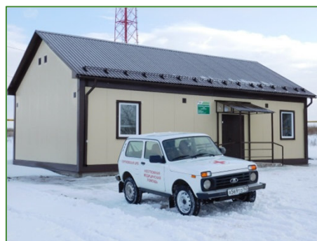
Строительство ФАП в с. В. Орлянка, п. Антоновка, п. Красные Дубки, уч. Сок, с. Калиновка и с. Спасское
