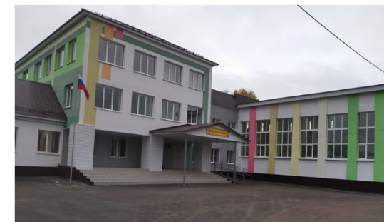
Капитальный ремонт ГБОУ СОШ (с. Кармало-Аделяково)
